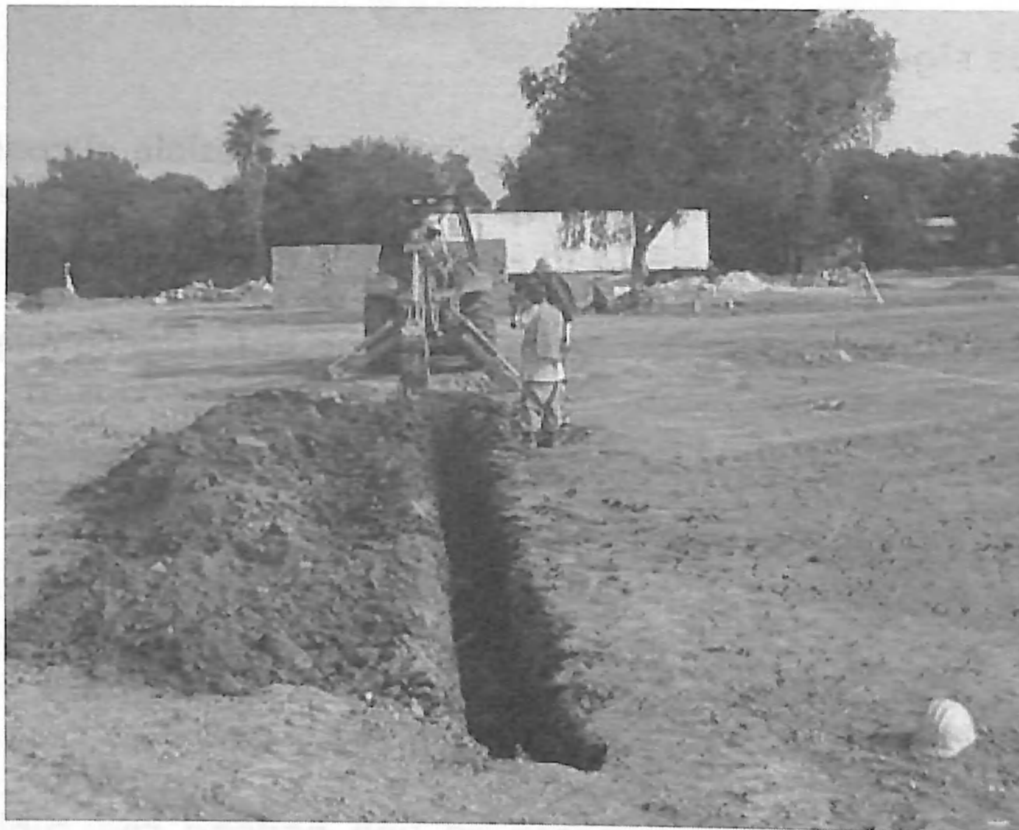
Tipo de maquinaria y equipo para excavaciones
