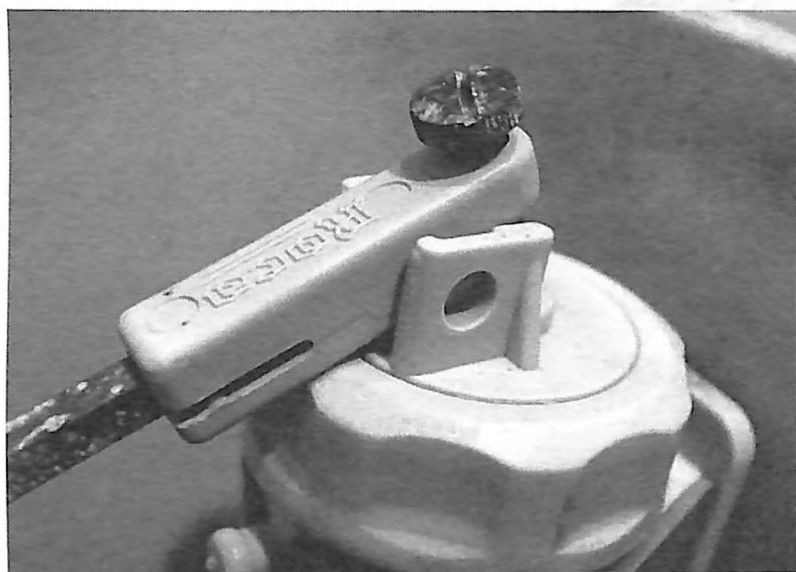
Forma de revisar las condiciones del dispositivo de entrada de agua mediante un destornillador
