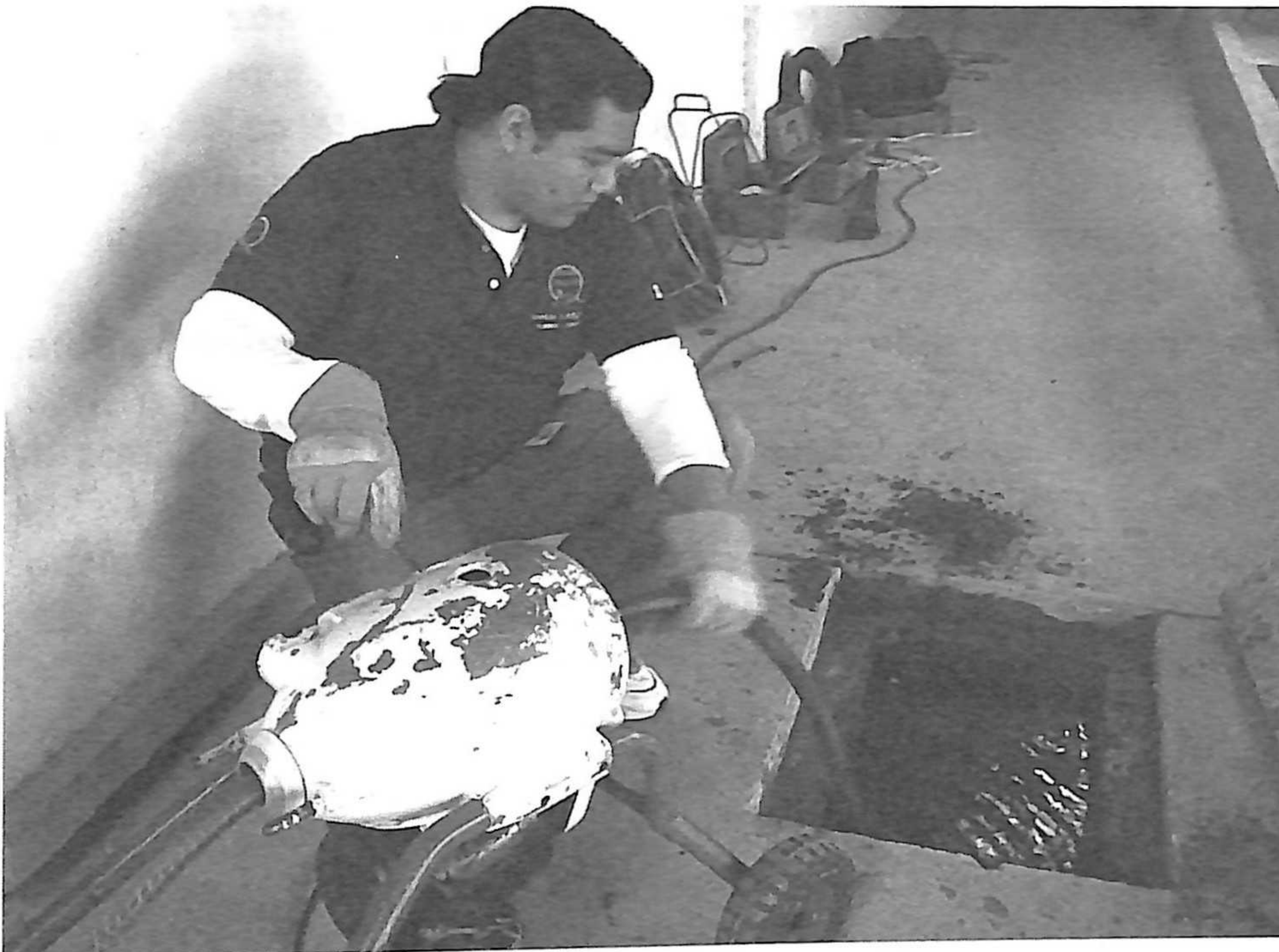
Destape de drenaje
