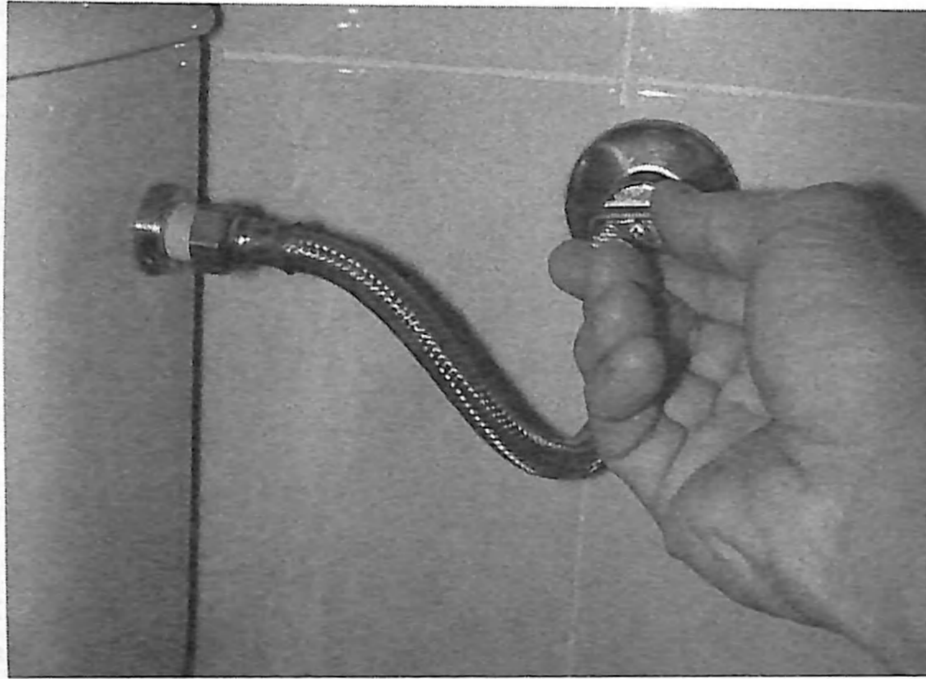
Forma de sujetar la llave para cerrar el paso de agua
